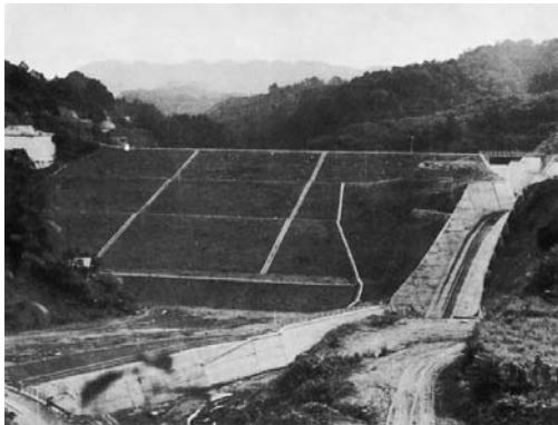
下流側から見たダム
