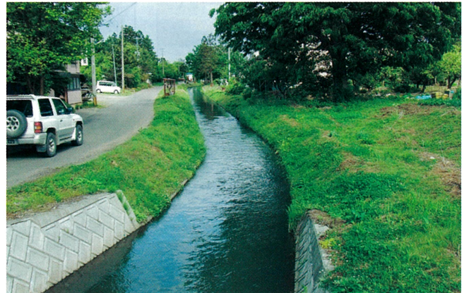
栗村幹線排水路（改修予定区間）
