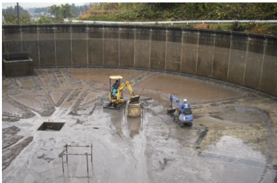
3号調整池内の土砂搬出作業(会津坂下町大字勝大地内)
