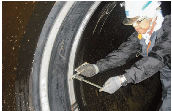
国営パイプライン内面バンド取付後の確認作業
