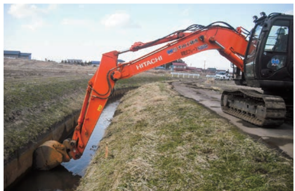
水路内の土砂撤去作業(会津美里町鶴野辺地内)
