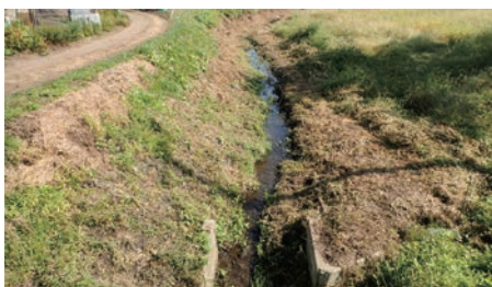
上流部施工前
