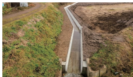
上流部施工後
