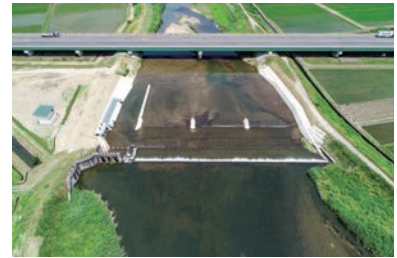
全景（令和2年度工事竣工時点）
