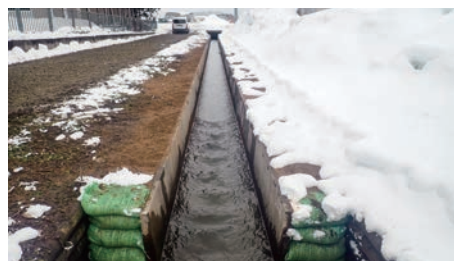
下流部施工後
