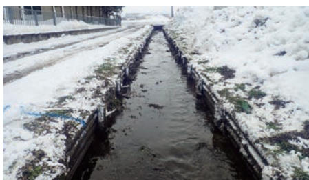
下流部施工前
