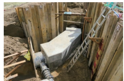
屈曲部のスラストブロック
