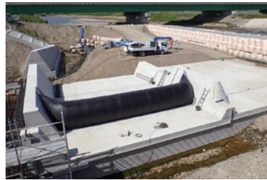
ゴム袋体の起伏状況
