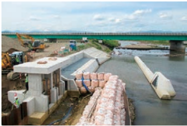
左岸取水口付近工事状況
