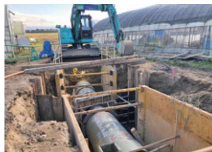
FRPM 管布設状況③
