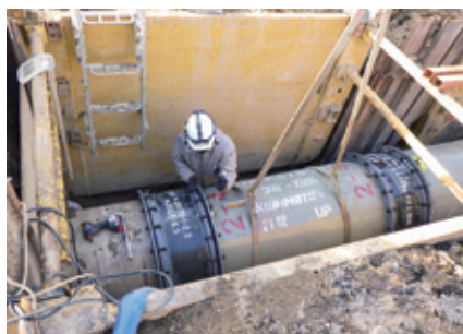
FRPM 管布設状況②
